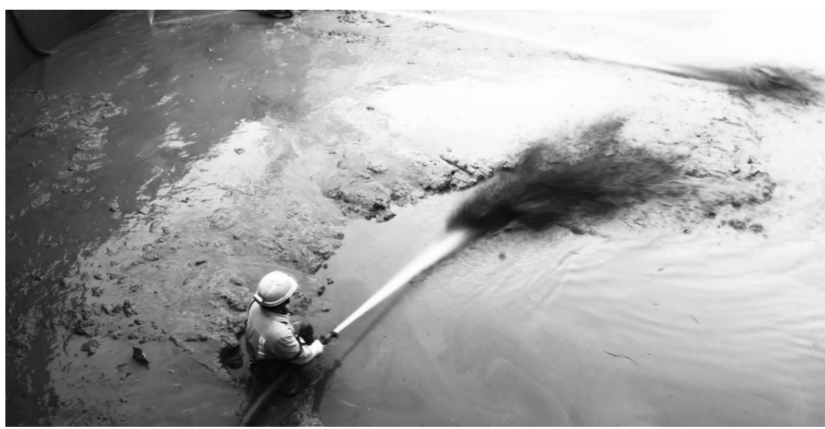
▲ 图为职工正在用高压水枪冲水池底部淤泥。 梅晓艳 摄
