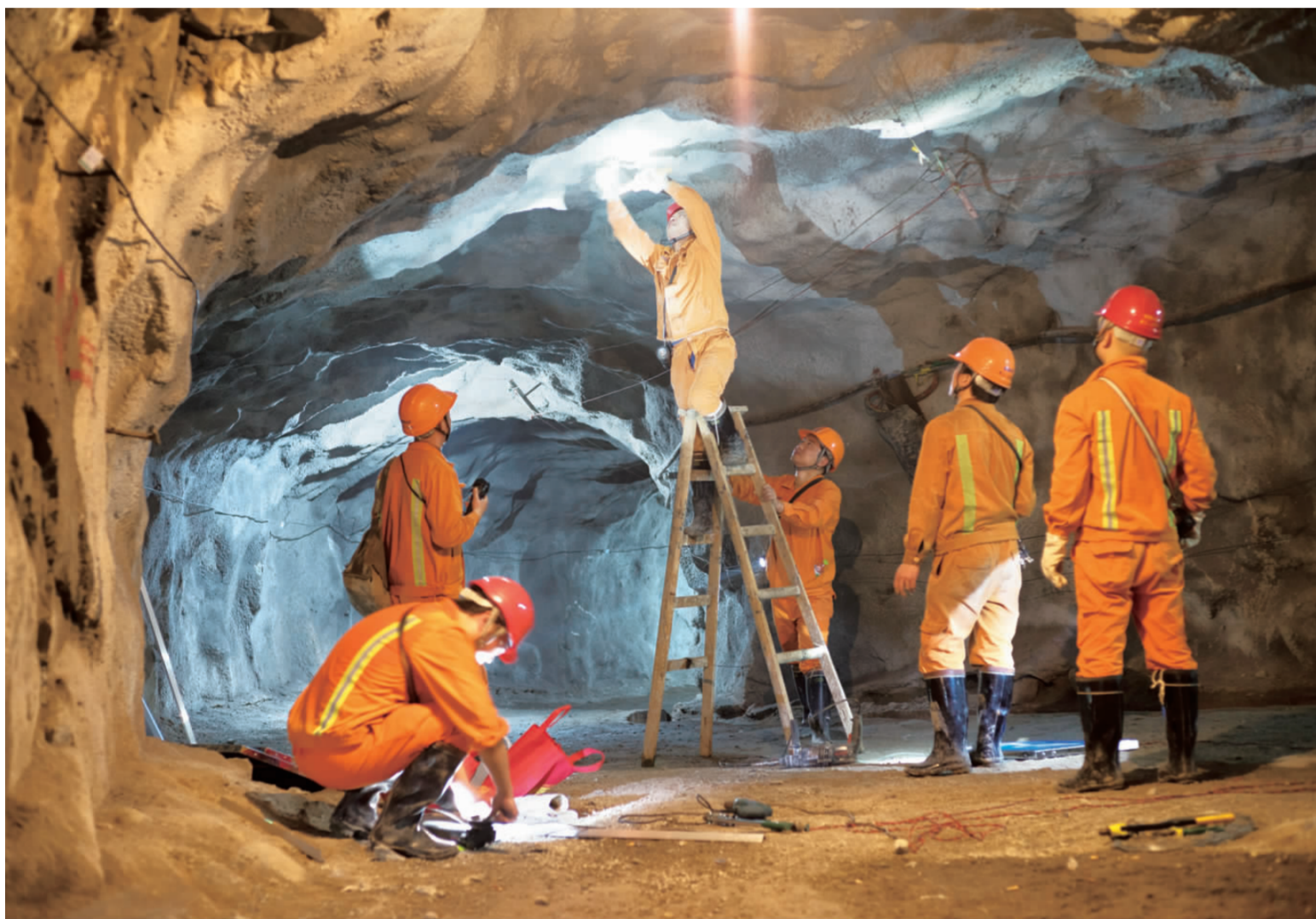
▲ 全面预算管理的施行,使基层班组定额管理、计量管理、经济核算水平都有了较大提高。这是铜绿山矿井下支护维修现场。(资料图片) 邱杰 摄
