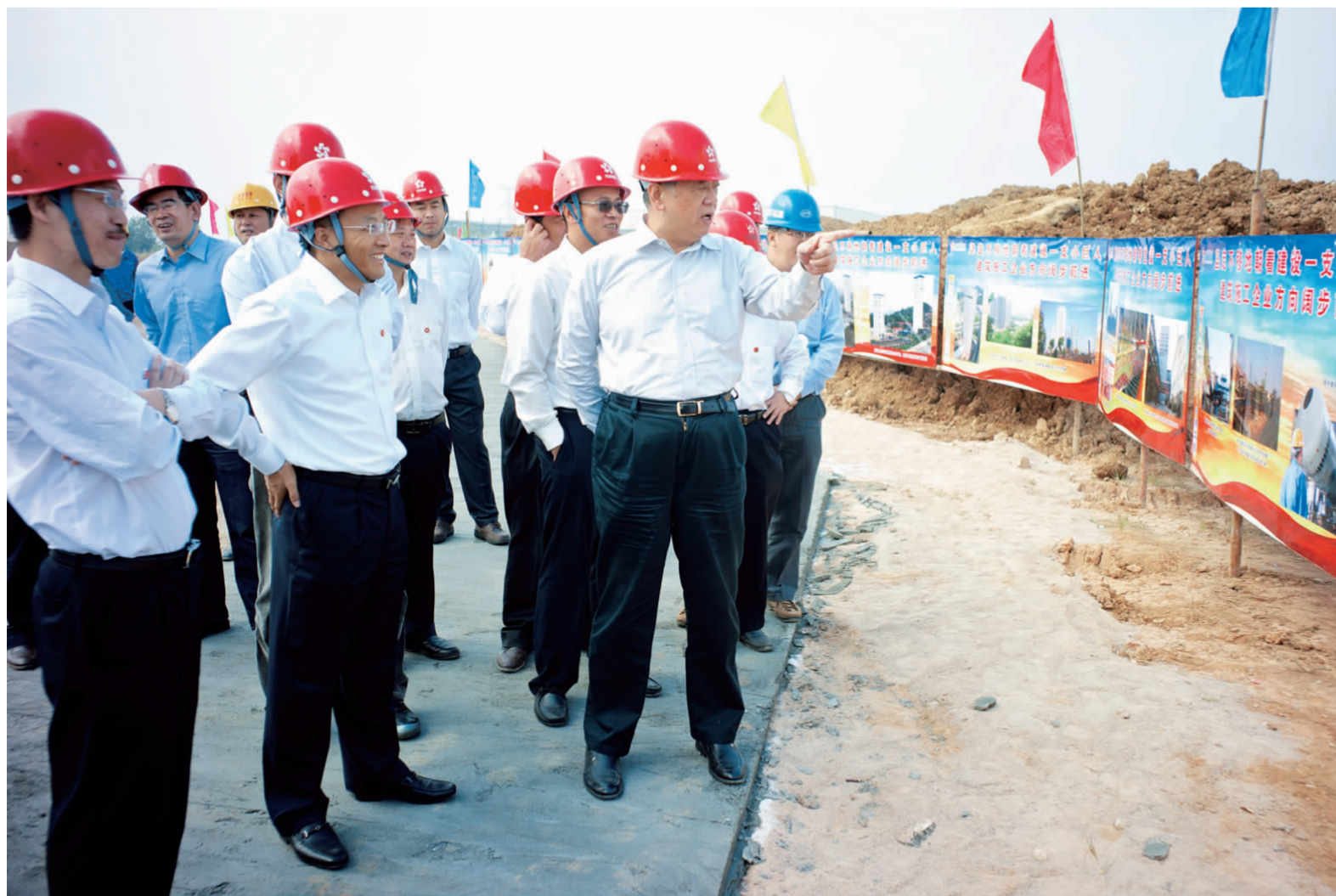
▼ 10月17日,罗涛总经理到机电修造公司项目建设工地查看施工情况。 邱杰 摄
